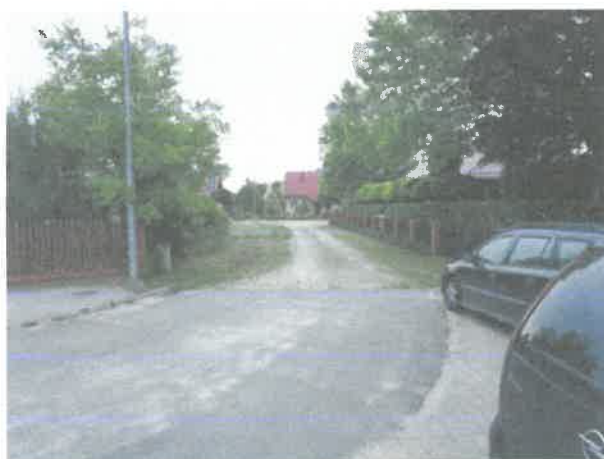
Widok na drogę dojazdową
