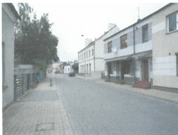
Widok na drogę dojazdową
